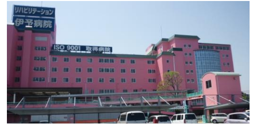
外壁塗り替え後
